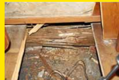
Bodenöffnung am nördlichen Gestühlsboden
